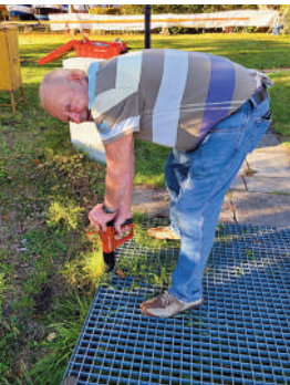
...Kontrolle der Steganlage...
