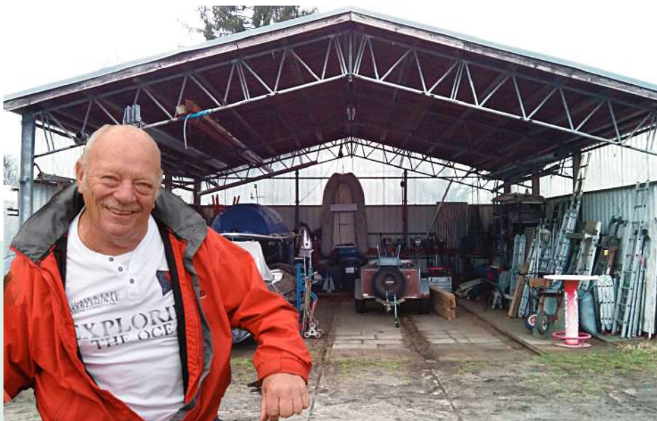
Die neue Lagerhalle ist nicht mehr die alte Bretterbude
